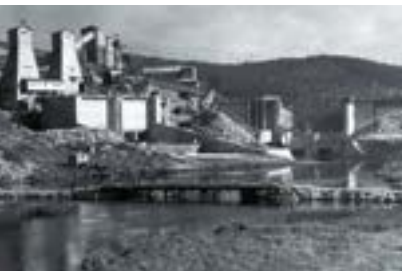
Výstavba hráze Lipno I (1952–1959)
